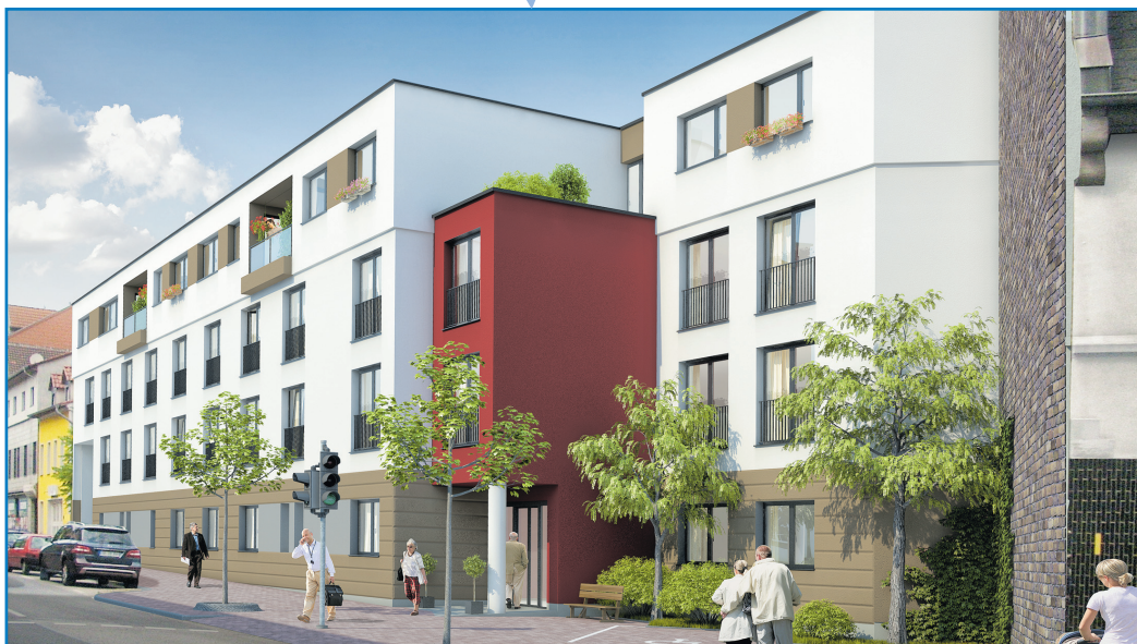
Seniorenresidenz: In kürzester Bauzeit konnte die Seniorenresidenz am Alten Rathaus in der Völklinger Innenstadt realisiert werden. Sorgfältig von der Stadt Völklingen mit dem Investor vorbereitet war das Millionenprojekt im November 2014 gestartet und wird nun nach dem Innenausbau bereits im Frühjahr 2016 eröffnet. Grafik: Investor
